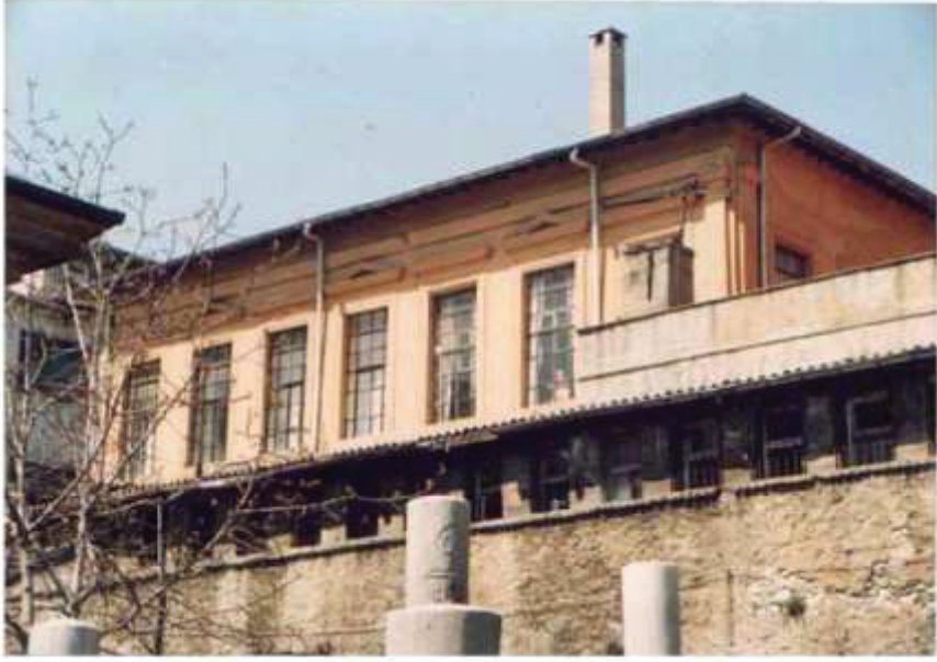
Resim 4- Valide Mektebi /Darülmearf 'in Güneydoğu (türbe) cephesi üst kat görünüşü.
